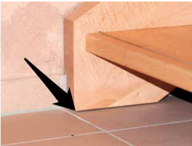
Die Wange „schwebt“, sie steht nicht auf dem Boden auf und ist auch nicht befestigt (schwarzer Pfeil).
